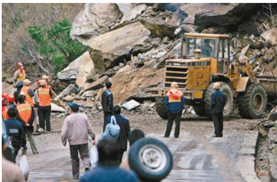
图七：108 国道在秦岭北坡发生片岩崩塌
