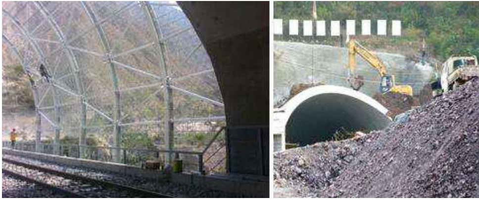
图十：隧道洞口明洞防护
