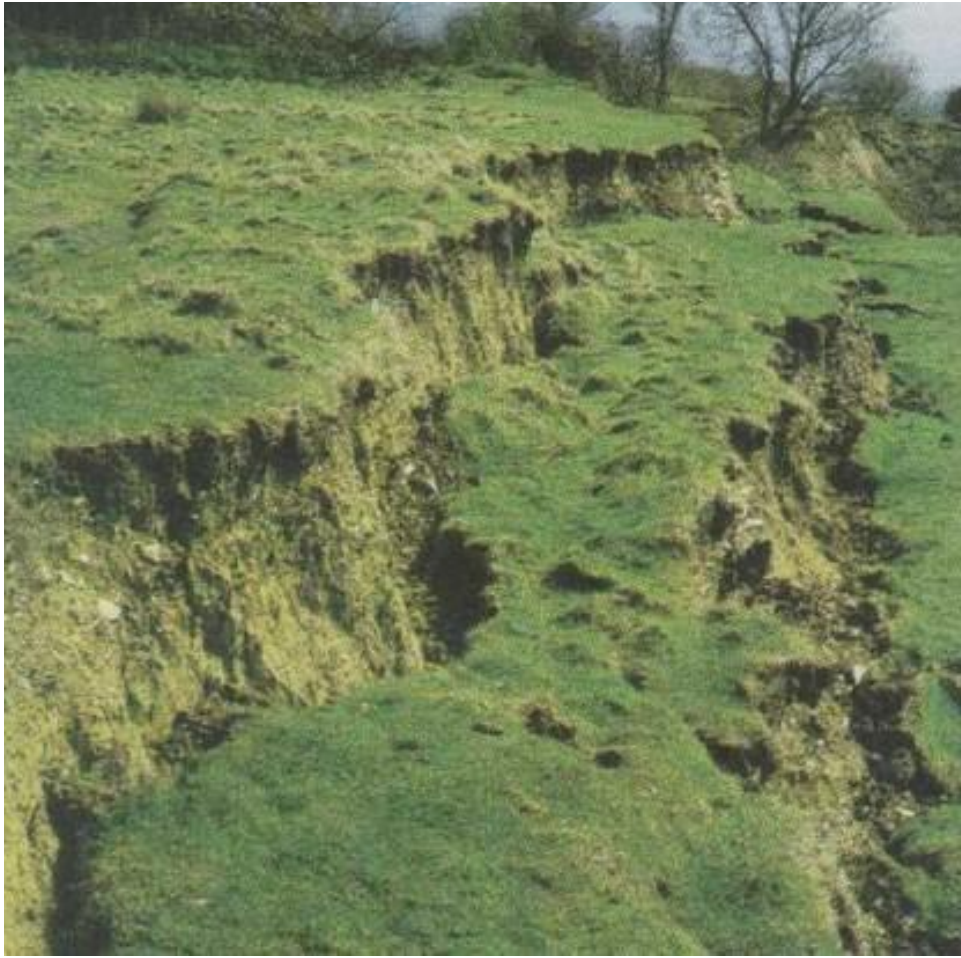
图二：滑坡后缘拉张裂缝（二）
