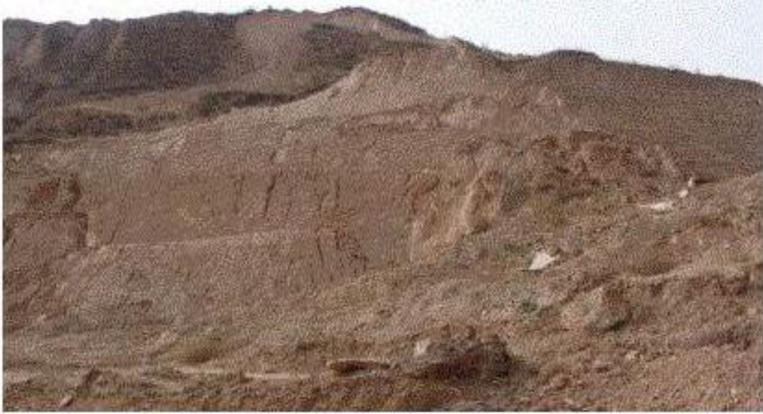
图五：滑坡前部的放射状裂缝
