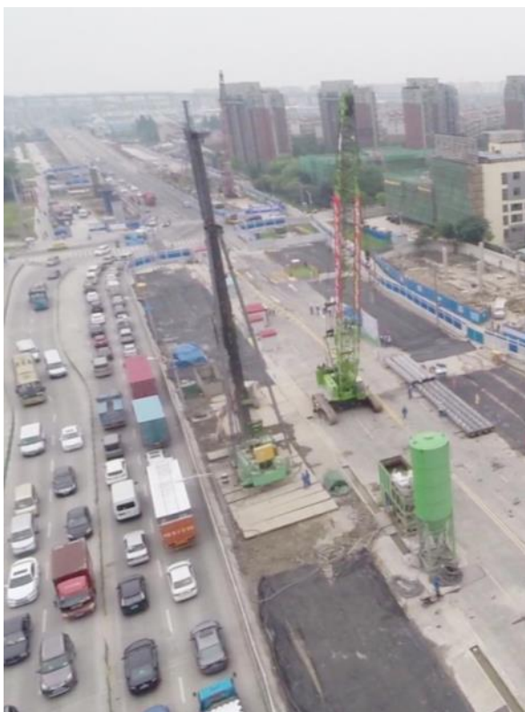
上海S26公路高架桥项目
