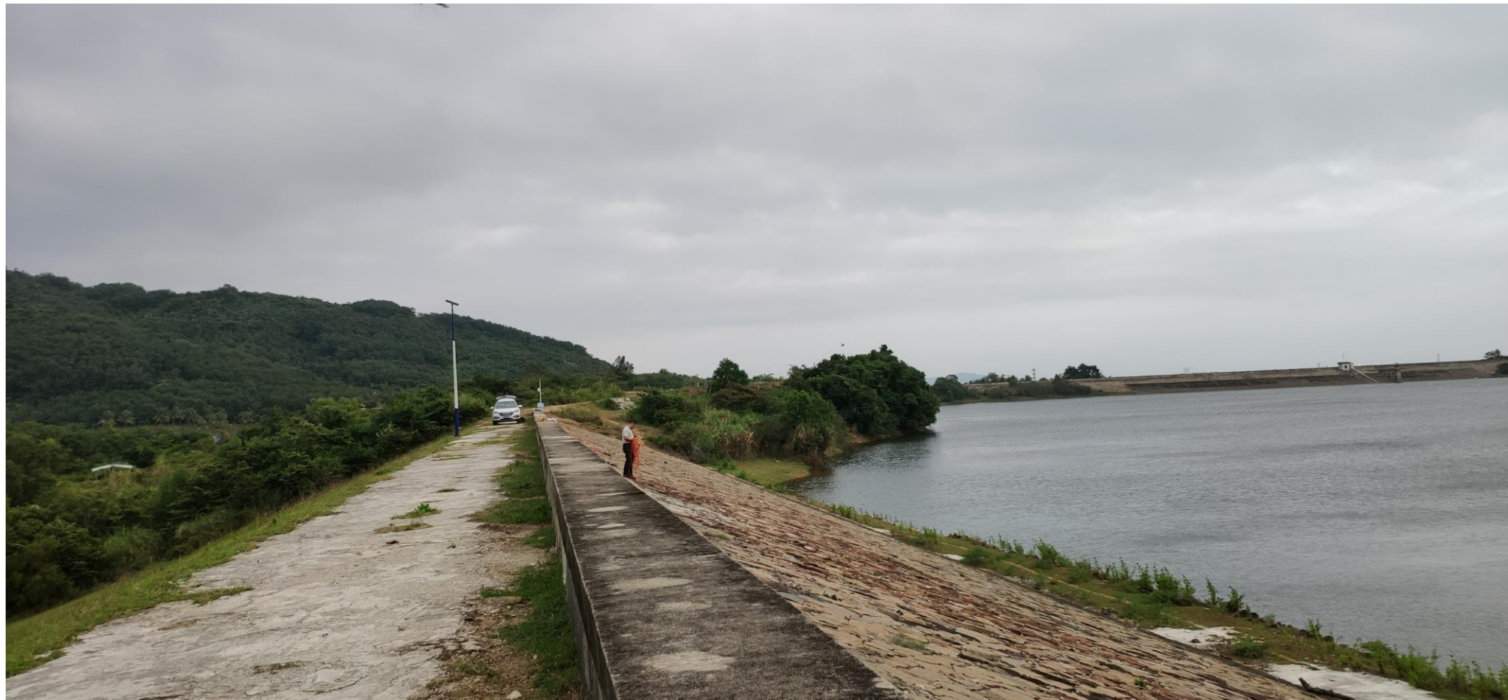
堤坝近景（迎水面）
