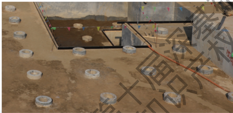
桩基施工完成
