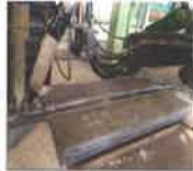
焊接工艺评定试板焊接
