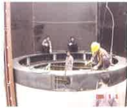
5m根式基础荷载箱现场图
