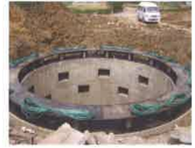
8m根式基础荷载箱现场图
