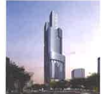
大吨位高层建筑测试
